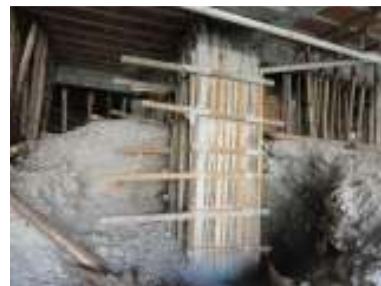
Figura 39 : Pilar P18 já reforçado
