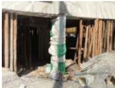
Figura 35 : Pilar da figura 40, envolvido para cura do concreto
