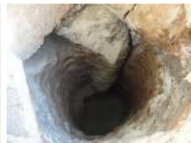
Figura 21 : Tubulão sem abertura de base
