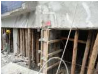
Figura 34 : Novo pilar sobre a viga da fachada
