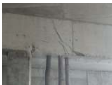
Figura 1 : Viga teto pilotis
