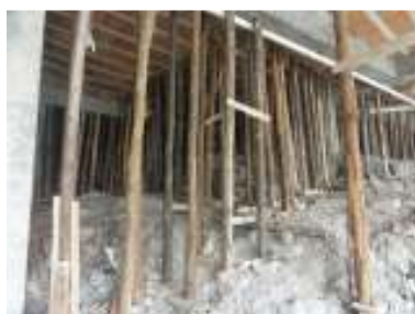
Figura 10 : Escoramento sob a laje da garagem
