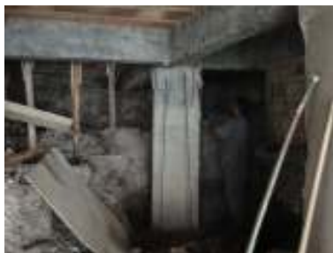
Figura 37 : Pilar P15 – rompido
