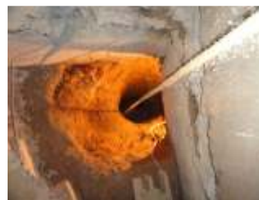
Figura 24 : Execução de tubulão sob pilar das figuras 7 e 8
