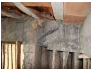
Figura 26 : Viga sobre a qual um pilar foi construído
