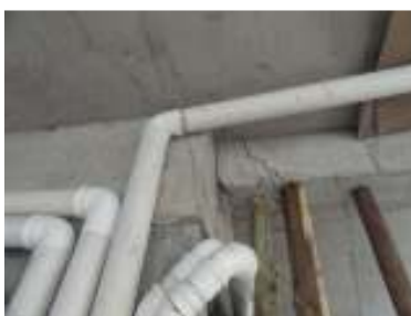
Figura 2 : Viga teto pilotis
