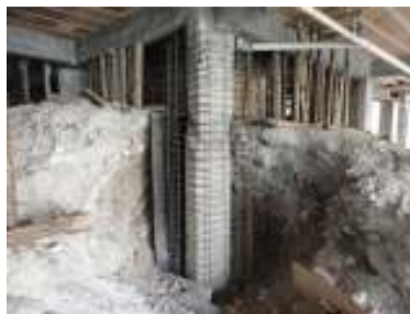
Figura 38 : Instalação de armaduras de reforço – Pilar P18
