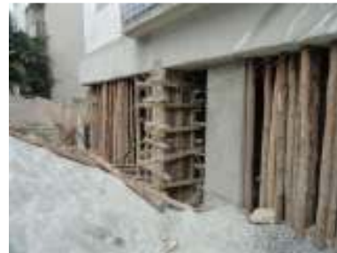
Figura 36 : Outro pilar novo, construído sob a viga da fachada
