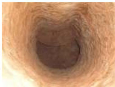
Figura 19 : Base de tubulão típico \varnothing_f=60\text{cm} e \varnothing_b=100\text{cm}
